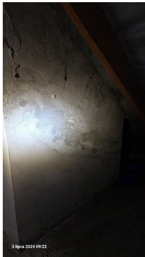
Rys. 21 Widoczne ślady przecieków na kominie
