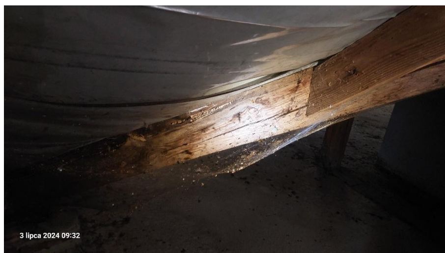
Rys. 17 Widok uszkodzonej krokwi koszowej (K-1)
