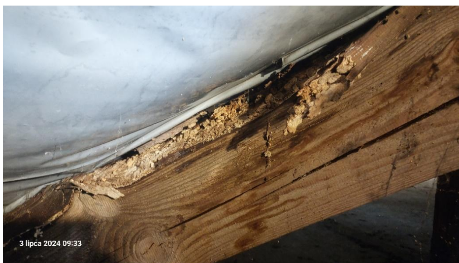
Rys. 14 Widok uszkodzonej krokwi koszowej (K-1)
