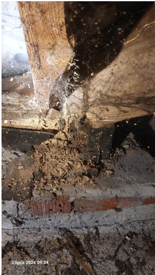
Rys. 18 Widok uszkodzonej murlaty
