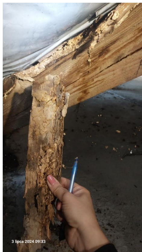
Rys. 16 Widok uszkodzonej krokwi koszowej (K-1)
