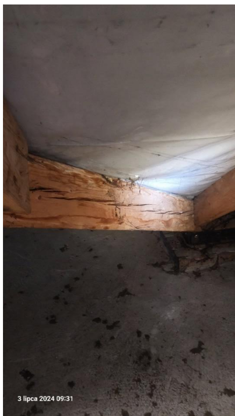
Rys. 15 Widok uszkodzonej krokwi koszowej (K-1)
