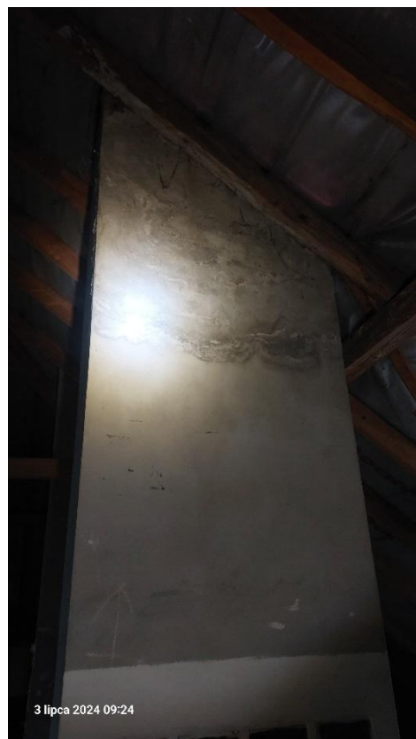
Rys. 23 Widoczne ślady zamakania na kominie
