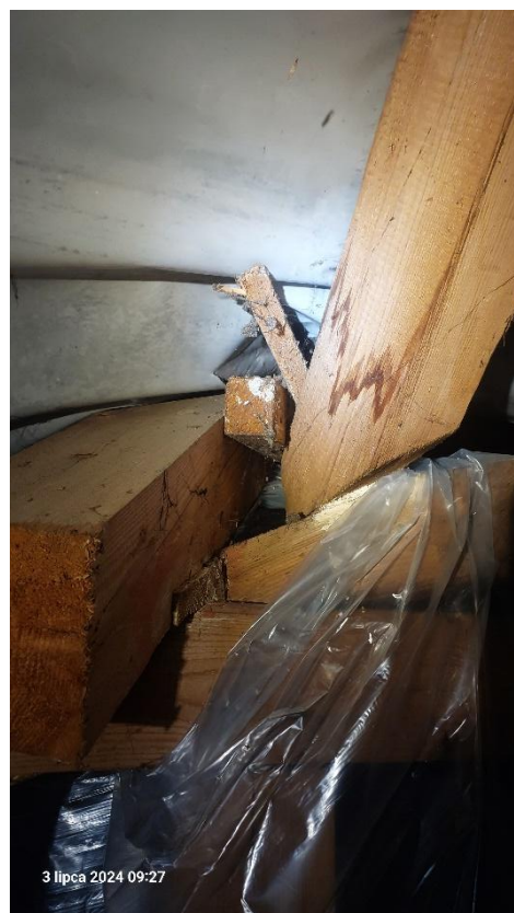
Rys. 25 Widok niedbale wykonanego połączenia.
