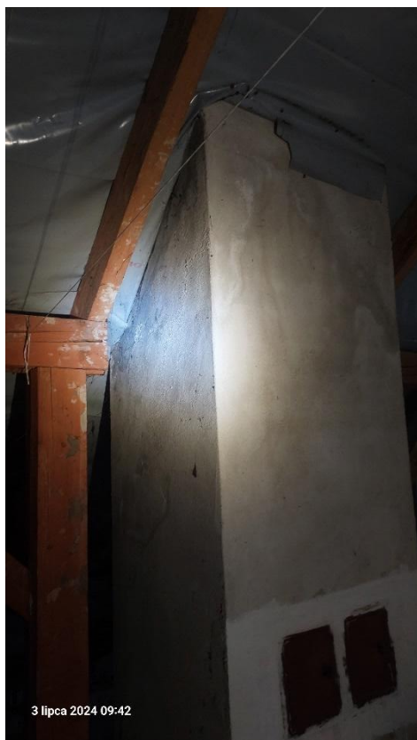
Rys. 22 Widoczne ślady zamakania na kominie
