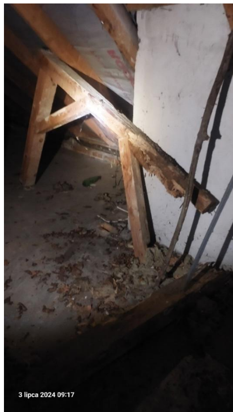
Rys. 13 Uszkodzona drewniana rama podpierająca krokwie i krokiew koszącą
